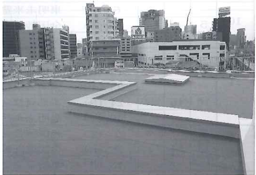
屋上部分 人工芝
